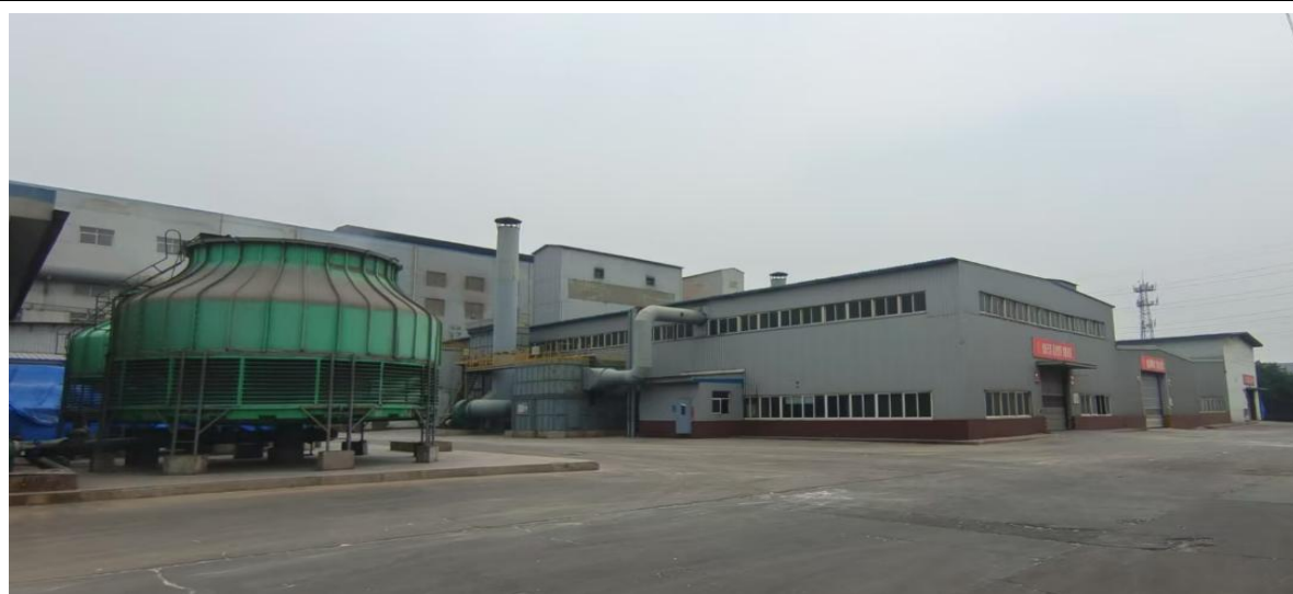
全封闭矿棉生产车间
